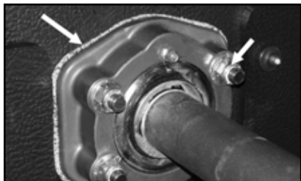
Resserrage des écrous (essieux intermédiaires)
