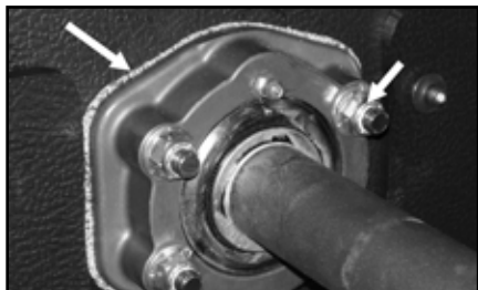
Resserrage des écrous (essieux intermédiaires)
